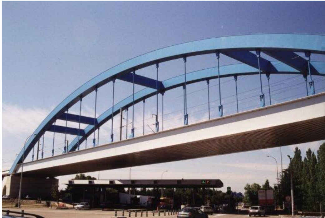
Pont en arc à tablier intermédiaire
