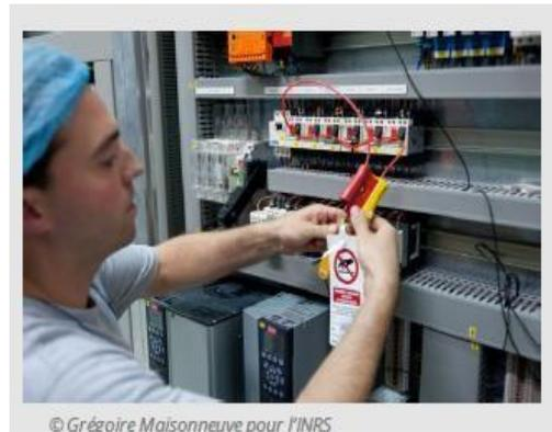
**Figure 9 :** Consignation dans un local technique pour intervention de maintenance électrique
