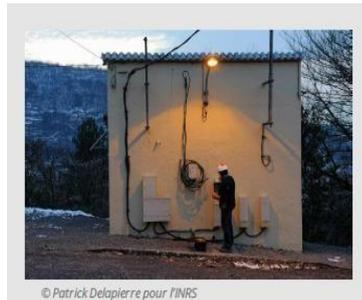
**Figure 7 :** Opérateur intervenant sur une armoire électrique à l'extérieur d'un bâtiment, afin de réaliser un raccordement au réseau de distribution
