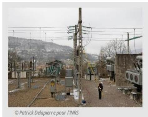
**Figure 8 :** Mise à la terre d'une ligne aérienne arrivant à un transformateur pour une opération de maintenance
