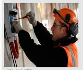
**Figure 6 :** Installation d'un éclairage provisoire avec branchement sur une armoire électrique murale
