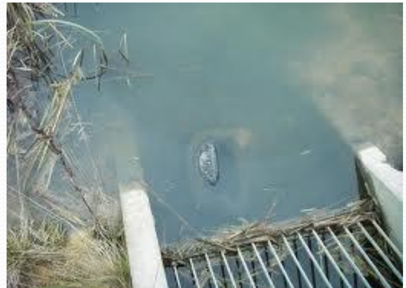
Exemples de flottants retenus par un dégrilleur.
