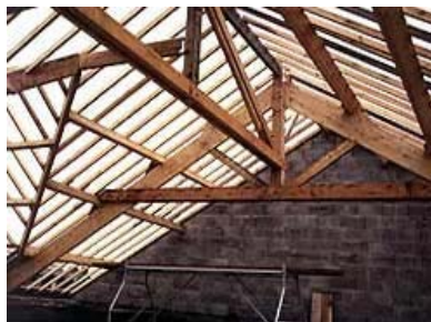
Charpente en bois
