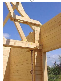
Poutres et poteaux
