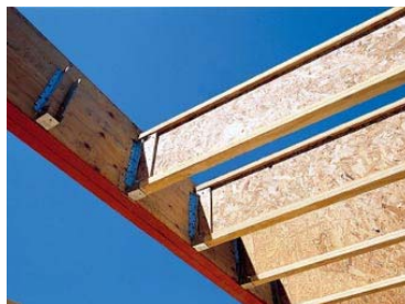
Poutre composite en I
