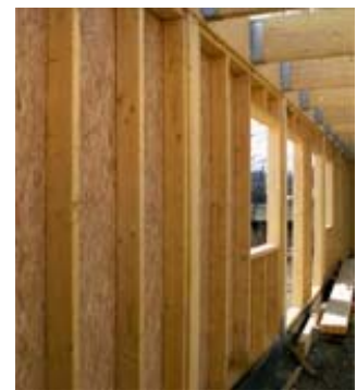
Dalles plancher/ Panneaux voiles
