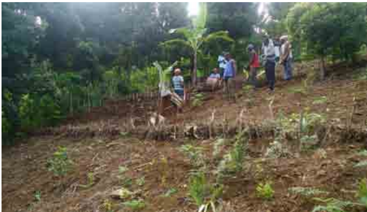
Travail collectif d'aménagement anti-érosif. Photo Amri Salim.
