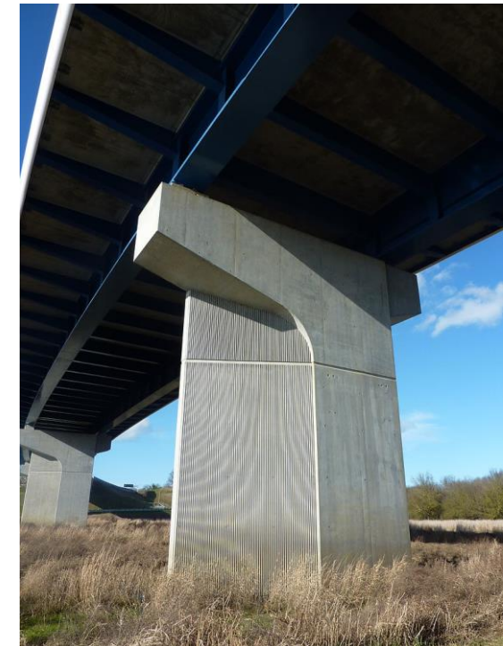
Viaduc de la Maine
