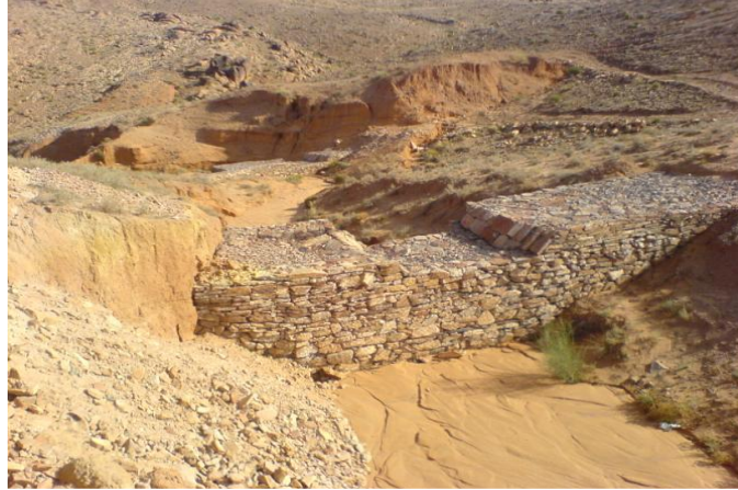
Photo 11: Les seuils en gabion utilisées dans la fixation des ravines (Melalih, 2012).
