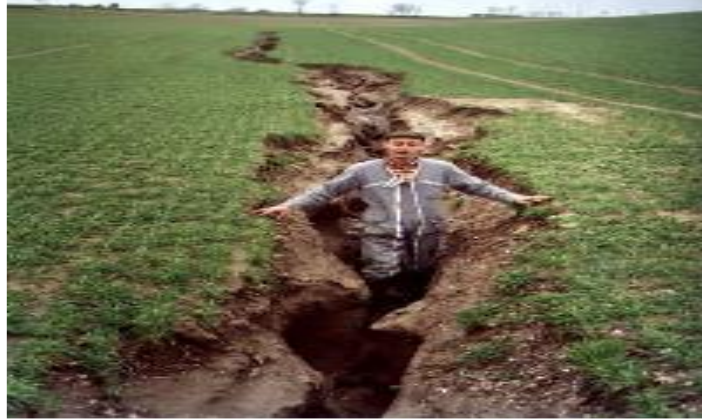
Photo 06 : Erosion en ravinement (SCPE, 2008).
