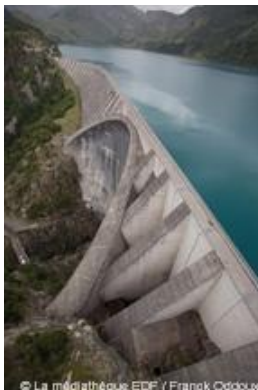
Barrage et retenue de Roselend (Savoie)
