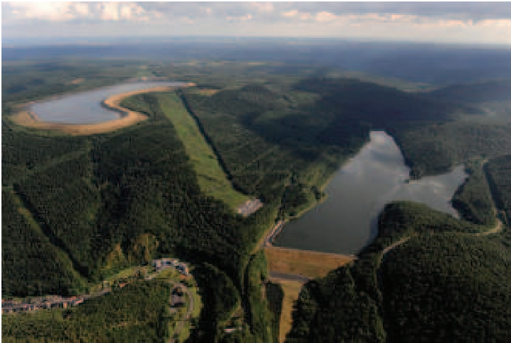
FIGURE 4.2 – Station de transfert d'énergie par pompage
