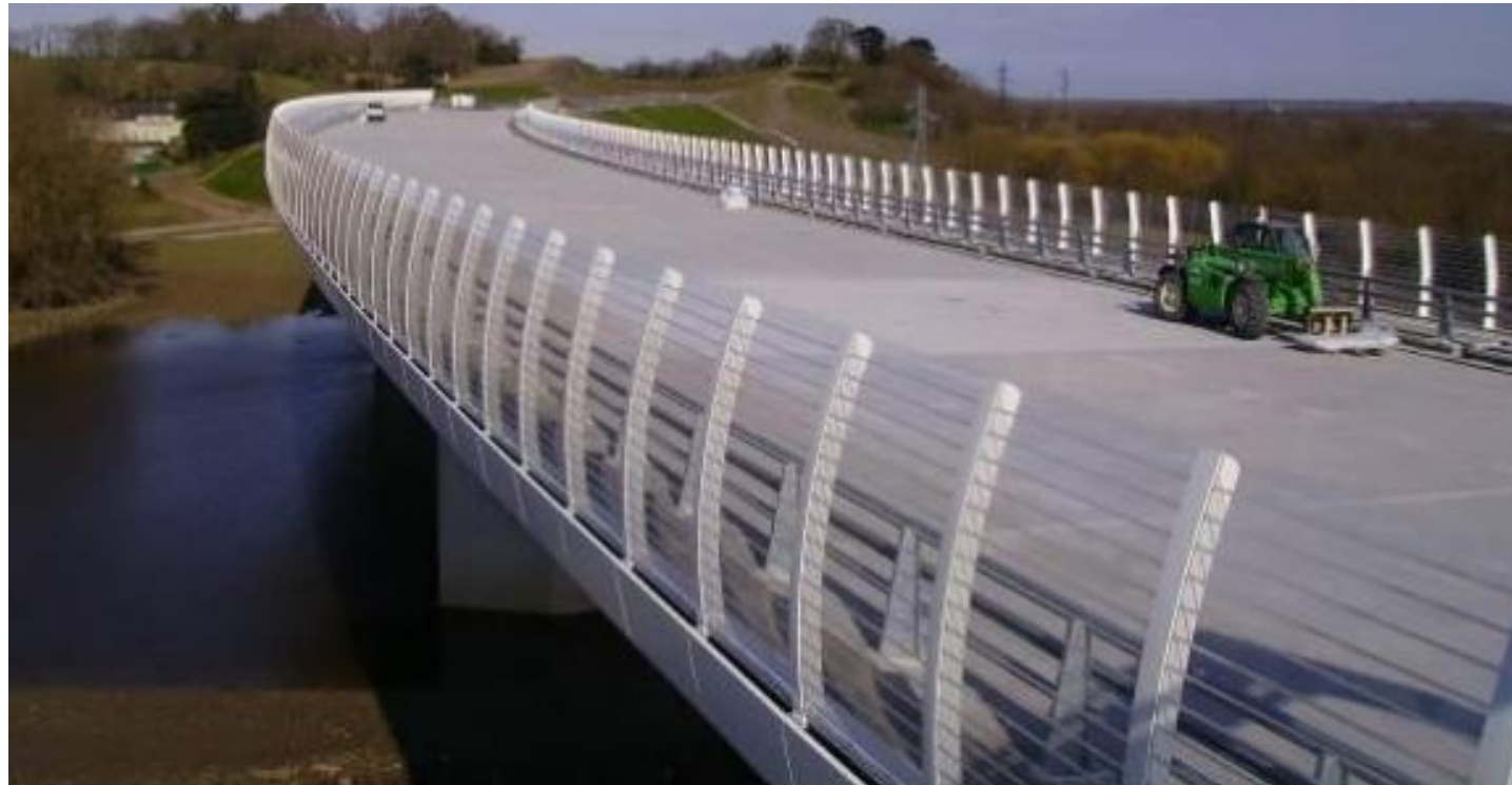
Figure 47 – Ecrans de forme courbe afin de réduire les réflexions multiples
