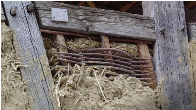
Fig.1.1: Le torchis (mélange de terre et de paille)
