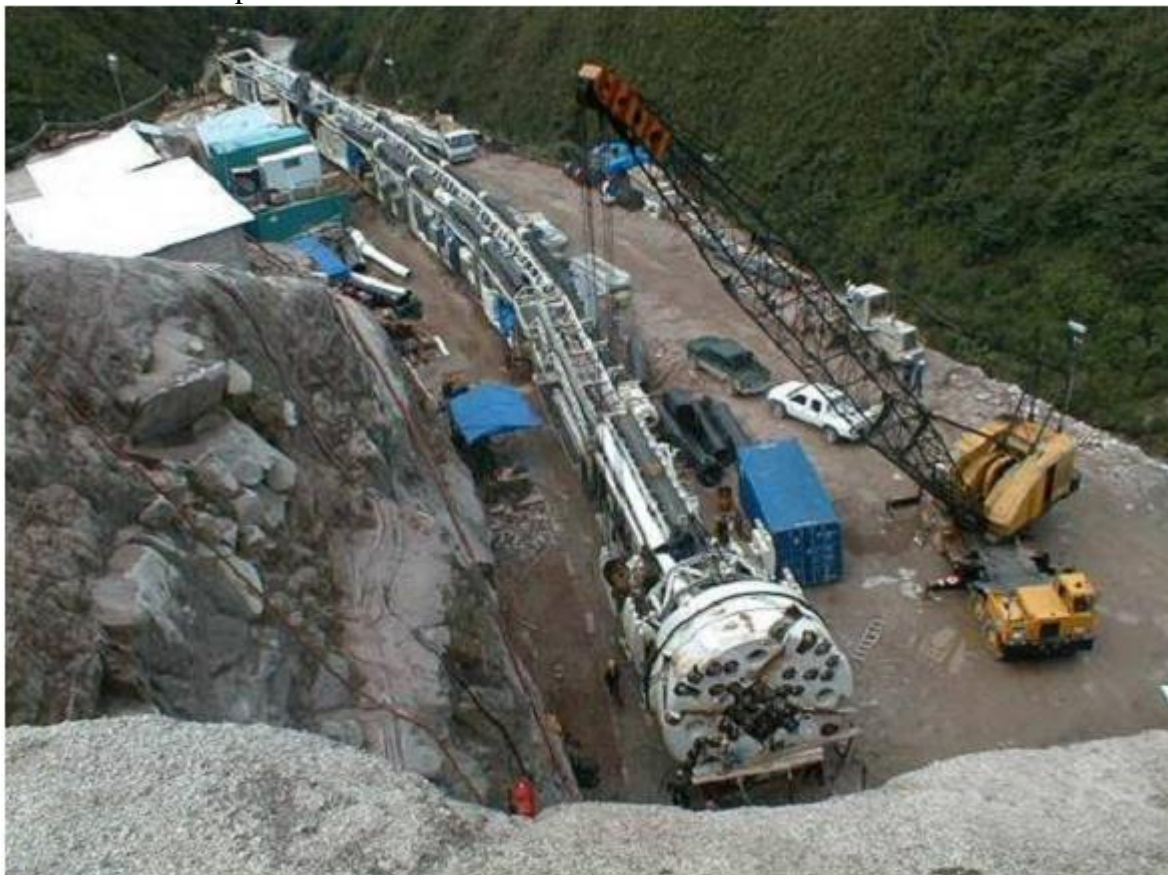
Figure 1. Tunnelier: Bouclier + train suiveur
