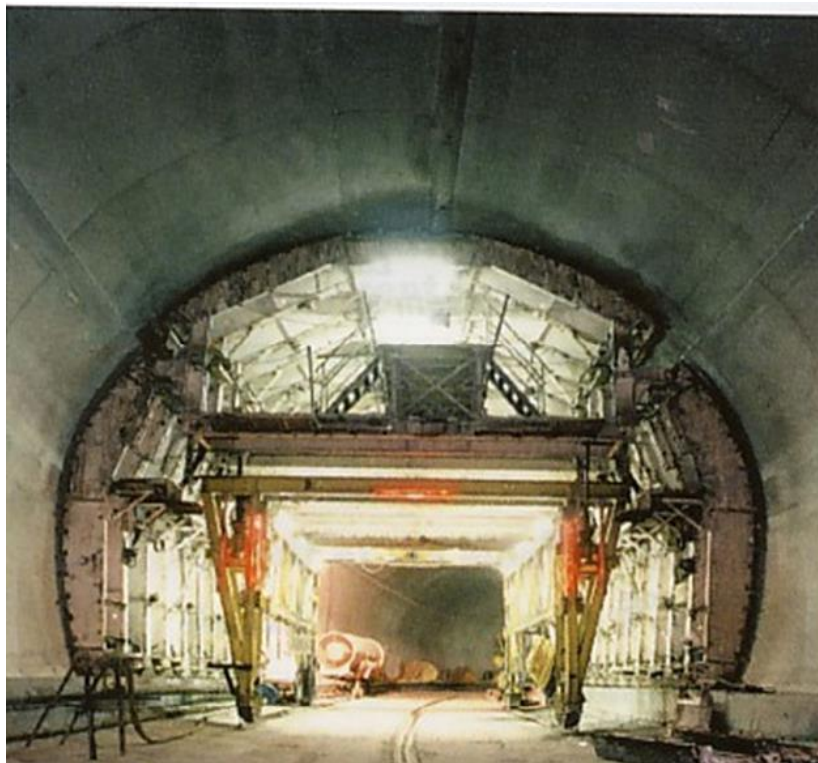
Figure 11. Revêtement avec coffrage glissant
