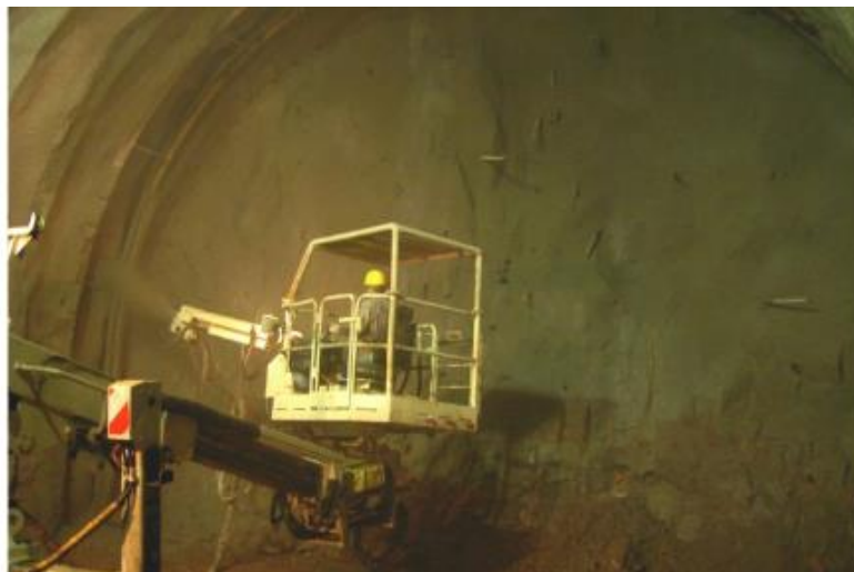
Figure 9. Béton projeté sur les parois latérales
