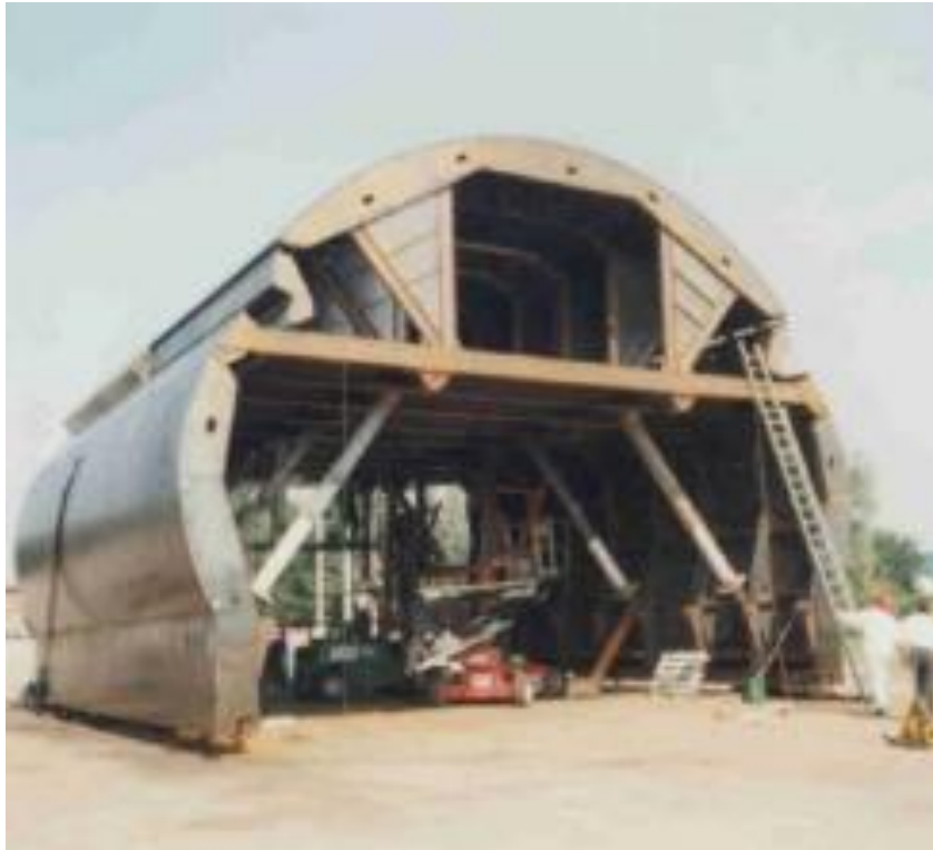
Coffrage métallique glissant
