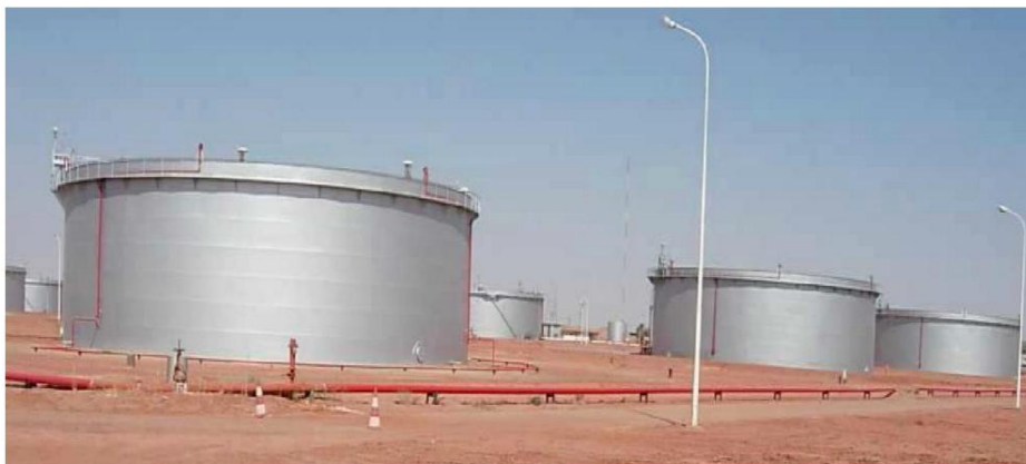
Figure1 : Réservoirs à toit flottant
