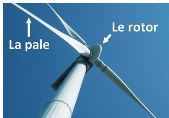
Figure 03 : Eolienne à axe horizontal (a 3 pales).
