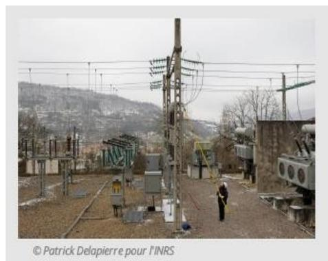
**Figure 8 :** Mise à la terre d'une ligne aérienne arrivant à un
