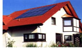
FIGURE 1.3 – Les capteurs plans (Aux plus complexes)
