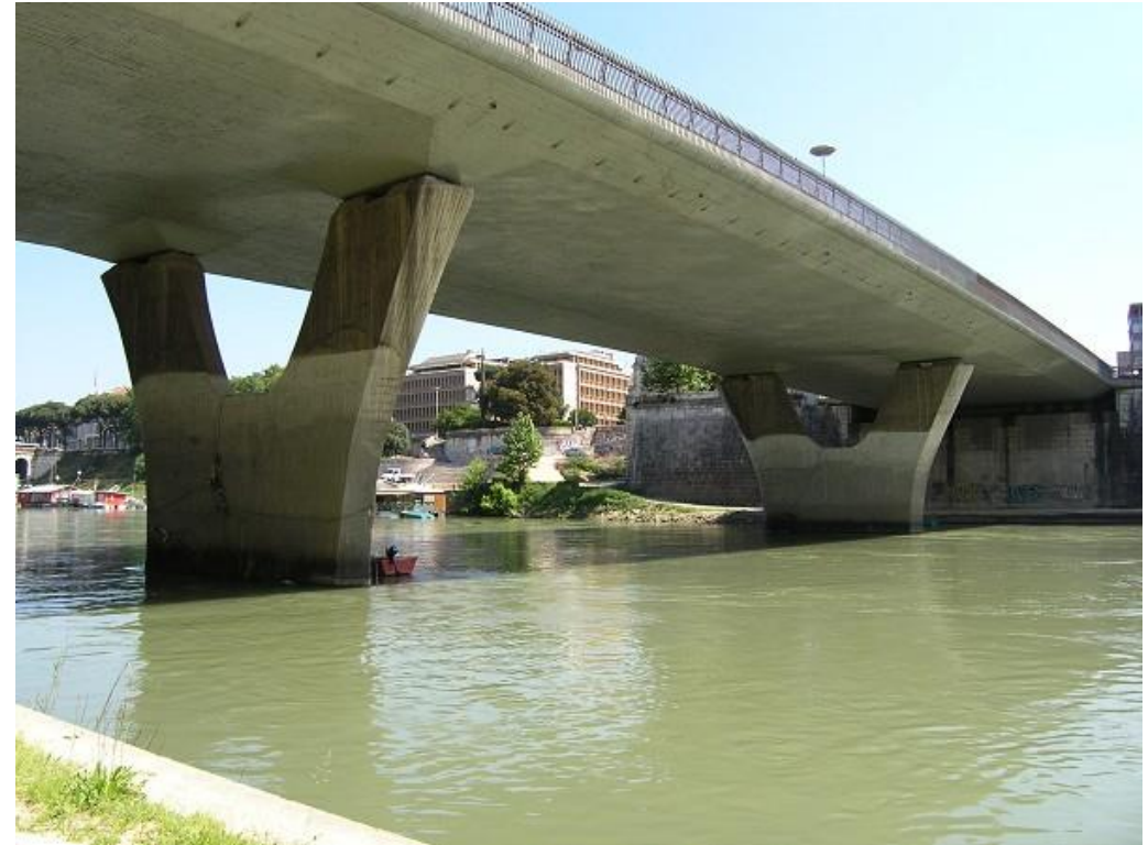
Pont à dalle précontrainte à encorbellement (PSIDP)
