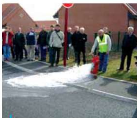
Démonstration de la perméabilité des enrobés poreux sur la résidence Delestraint, Lambres-lez-Douais
