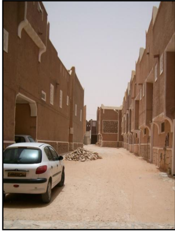
La voiture intègre le ksar
