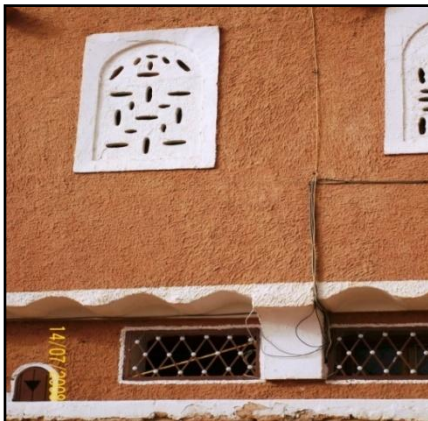
Protection des ouvertures et texture rugueuse
