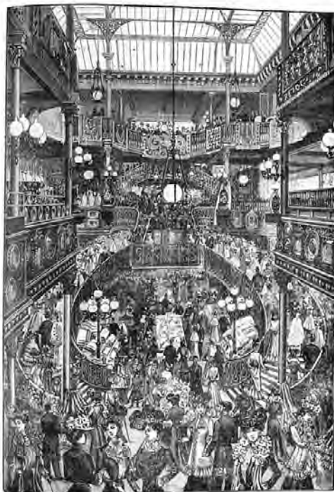
Vue générale aérienne du Bon Marché en 1880.
