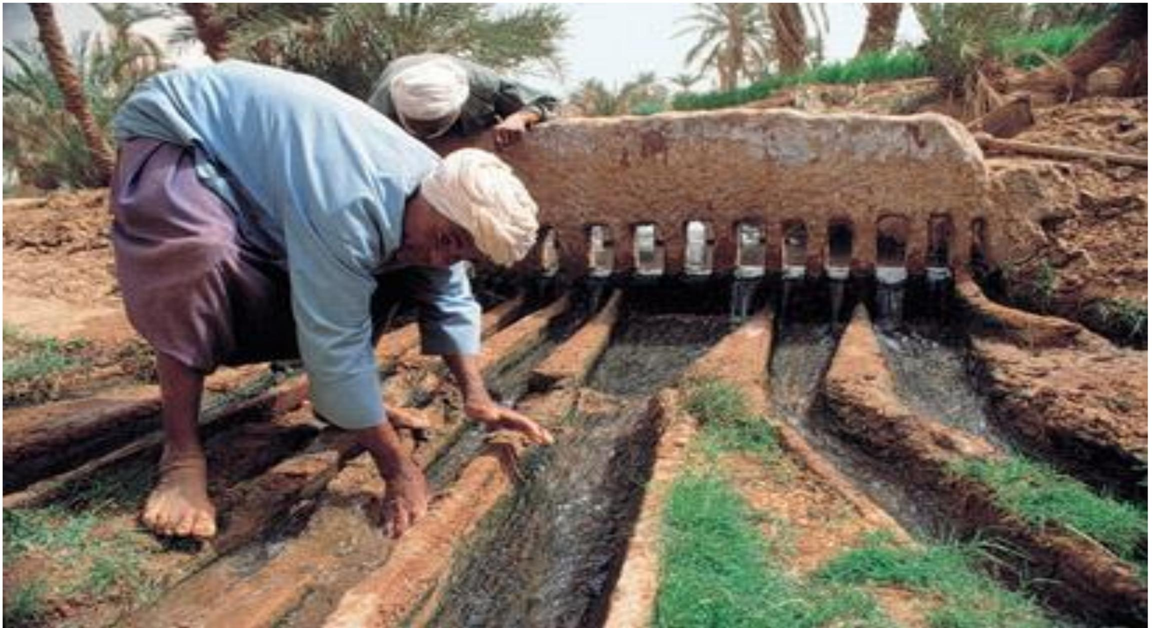
**Figure.** La Foggara permet de distribuer l'eau dans l'oasis permet de distribuer l'eau dans l'oasis
