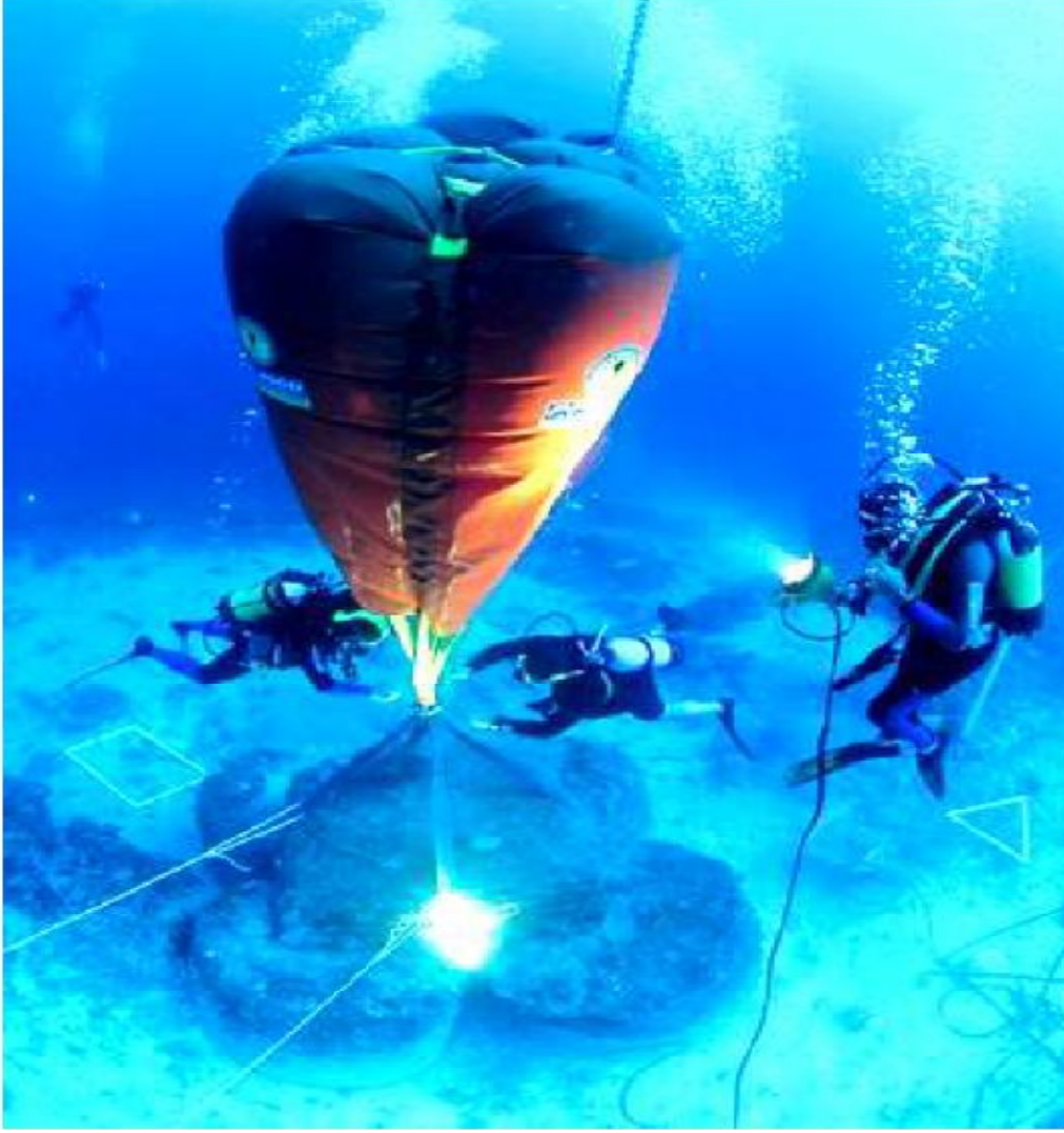
صورة تمثل استخدام البالونات في رفع الآثار الغارقة تحت الماء
