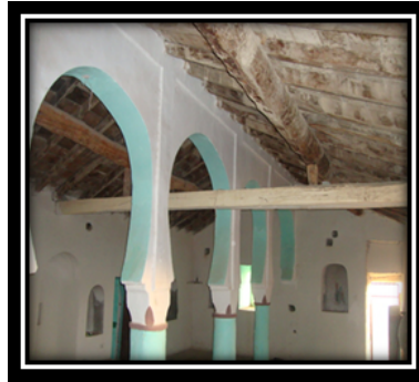
الصورة 12: تدعيم سقف المسجد الجامع للقرية أقمون.
