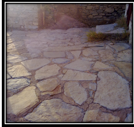
الصورة 16: إعادة تهيئة أرضية الشوارع بالقرية أقمون.
